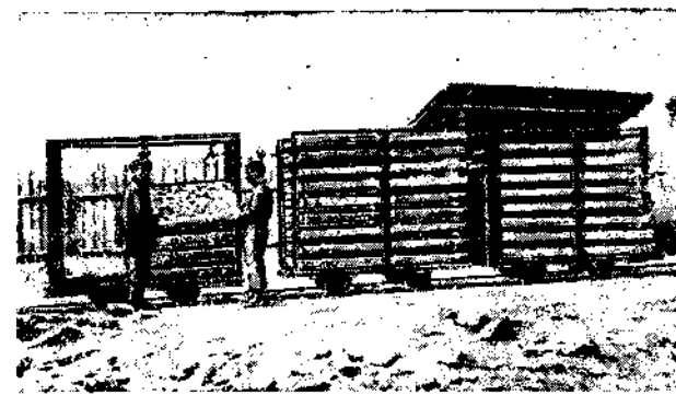
Рис. 31. Загрузка сушильных сит со щепой на вагонетки сушилки
